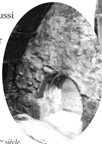
de la partie supérieure de la « bachole », l'eau chutait sur la roue en contrebas
