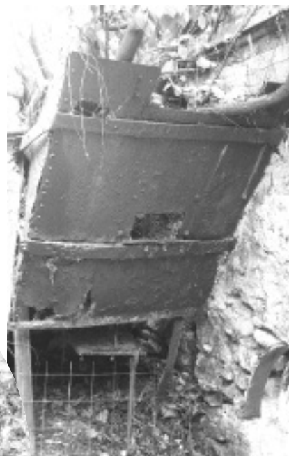
de la partie supérieure de la « bachole », l'eau chutait sur la roue en contrebas
